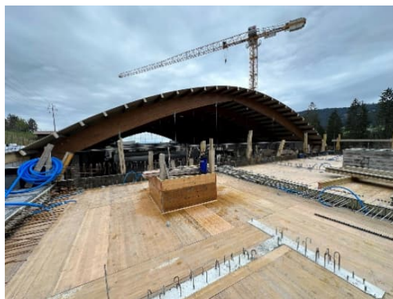
Coffrage de la dalle des locaux techniques
