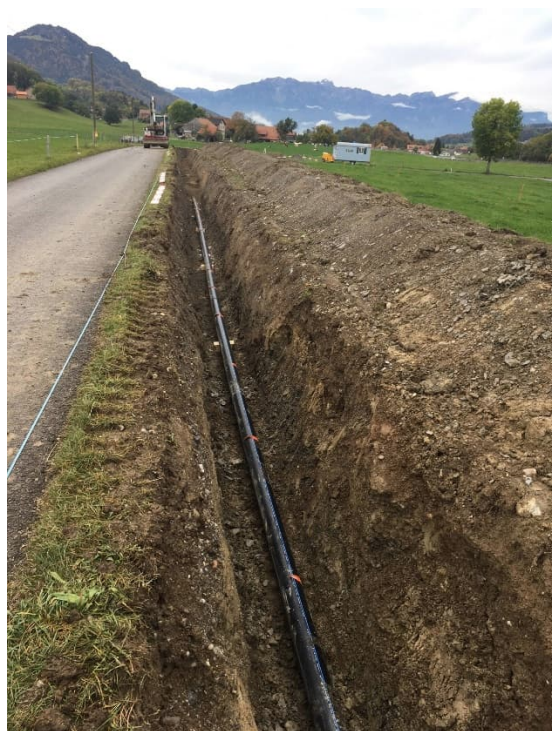
Chemin du Mollard : remplacement conduite et borne d'hydrante
