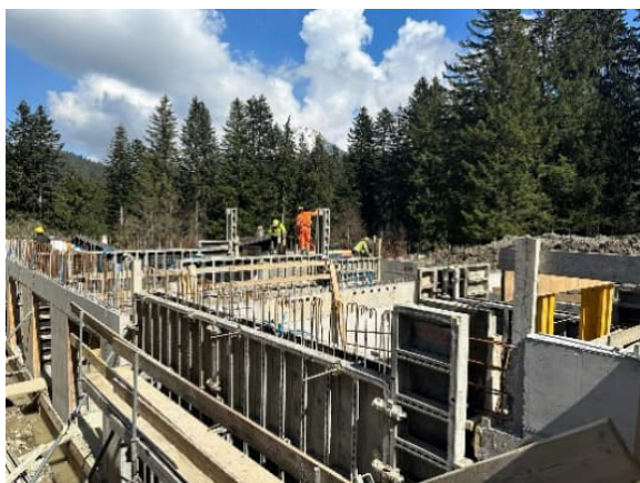
Construction des murs des locaux techniques
