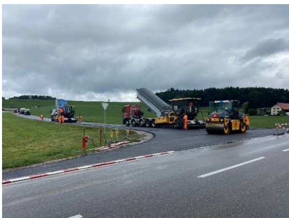
Pose de la couche de roulement finale
