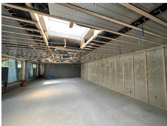
Locaux du restaurant, à l'état brut
