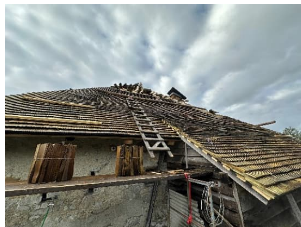
Durant les travaux
