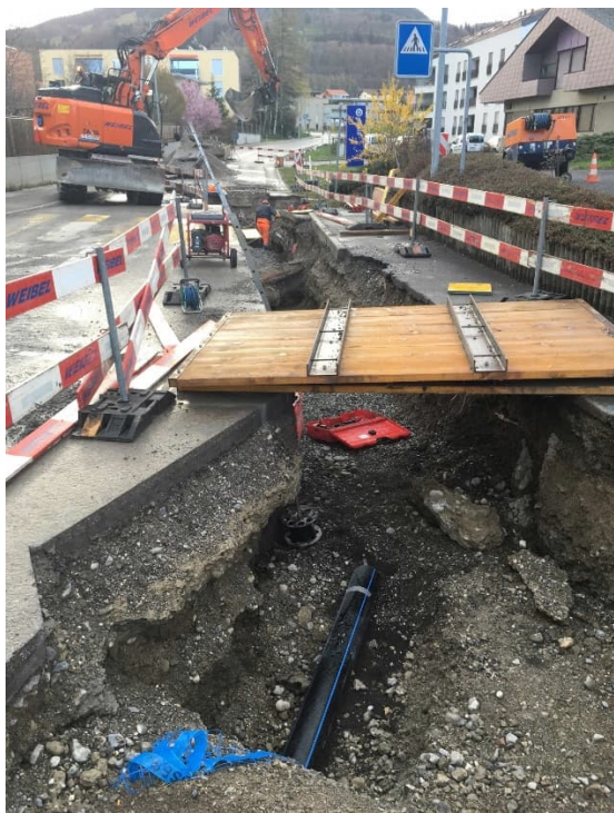
Le Dally : pose nouvelle conduite et borne d'hydrante
