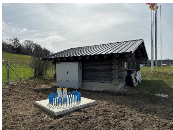
Socle et armoire technique prêts à recevoir leur mât
