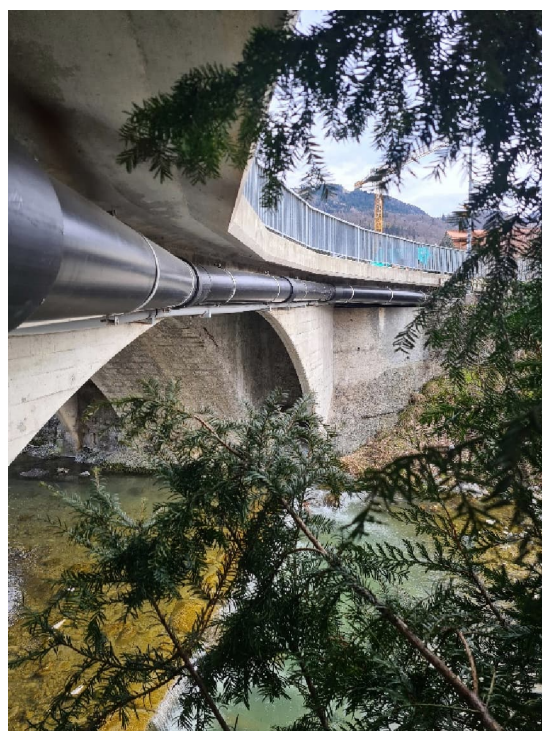
Pont des Granges : pose conduite isolée
