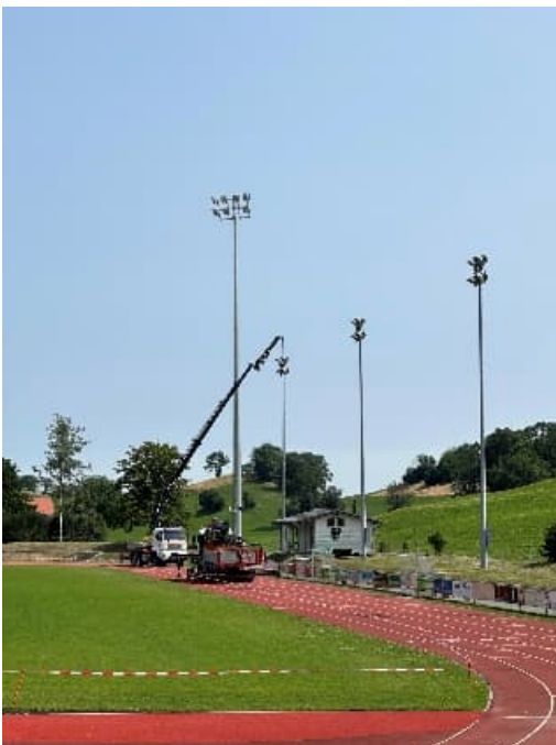
Démontage des anciens mâts et des socles provisoires
