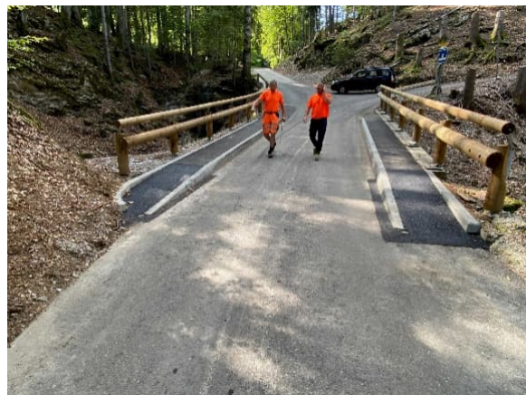
Modification trottoirs avals
