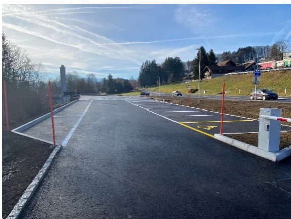
Revêtement couche de base
