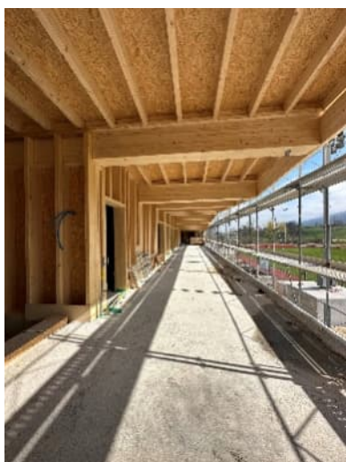
Terrasse de l'étage
