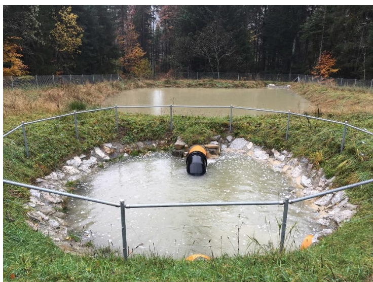
Les Braseyres : bassin de rétention avec dépotoir lors d'une forte pluie
