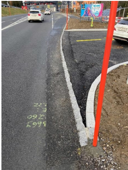
Route de Vevey – Arrêt de bus
