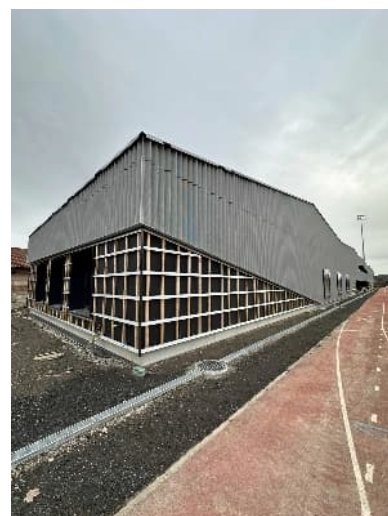
Habillage des façades
