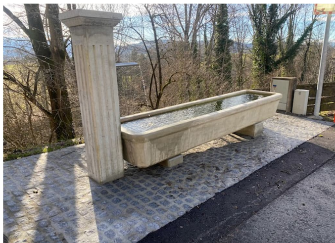
Après les travaux
