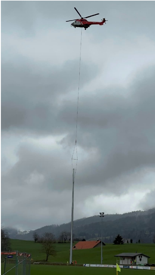
Mise en place du mât n° 3 à l'aide d'un hélicoptère
